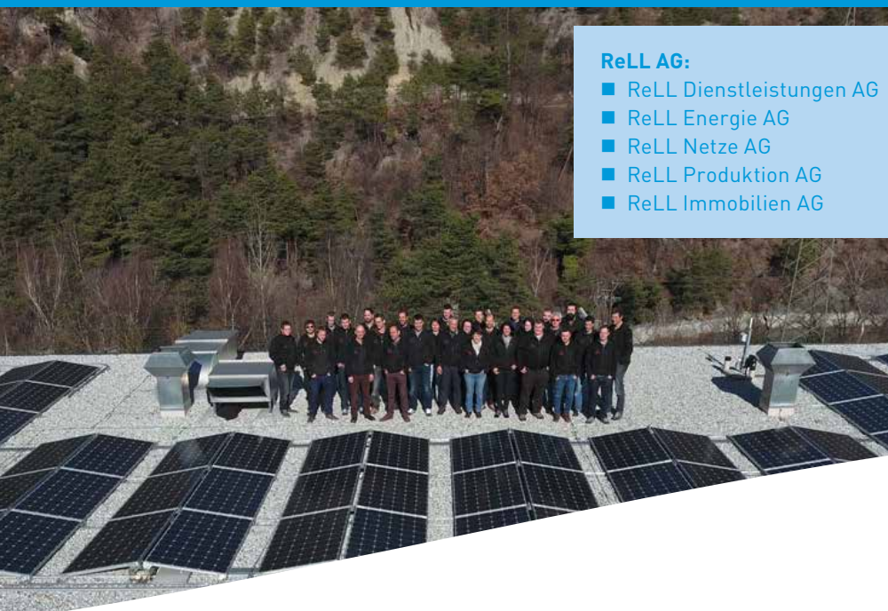
Foto: Photovoltaikanlage Verwaltungsgebäude ReLL, Susten
