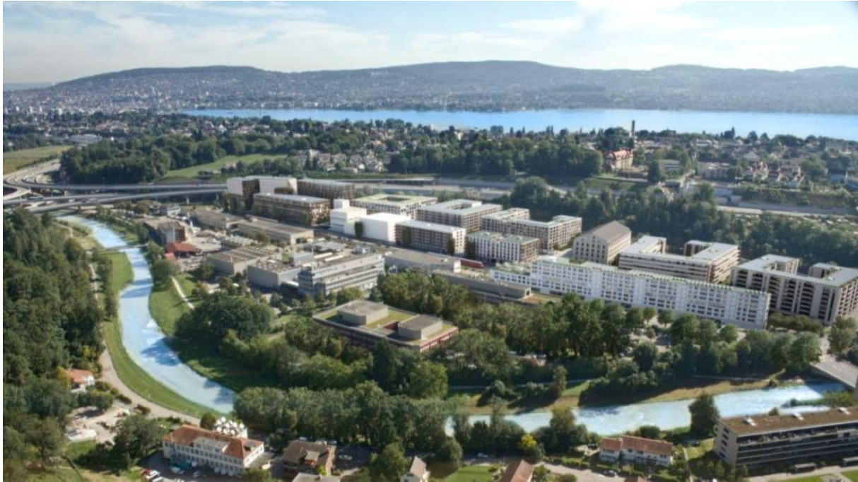
In Zürich-Wollishofen entsteht Greencity, das erste zertifizierte 2000-Watt-Areal der Schweiz.
