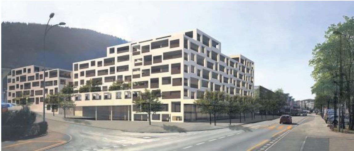
Überbauung Grossmatte West im Luzerner Stadtteil Littau
