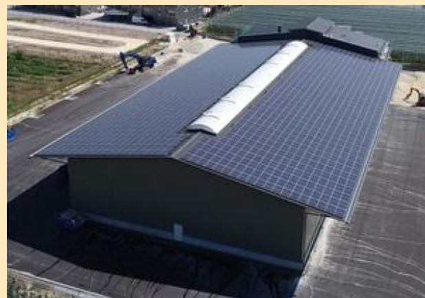
2018: Obsthalle Bodman 378 kW
