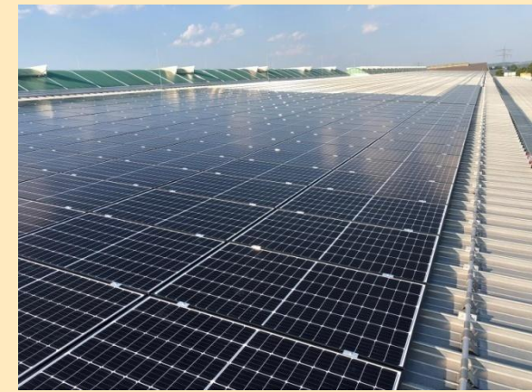
2019: Schako Messkirch, 750 kW
