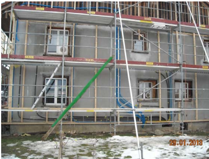
Bild 2: Leitungsführung in der Dämmebene. Die schwarzen Rohre sind Heizleitungen, die blauen Rohre für Elektrokabel.
