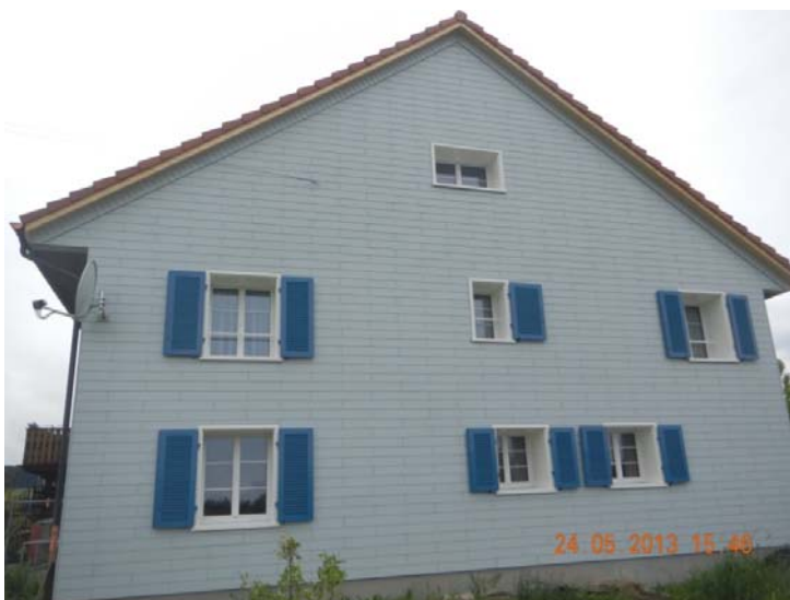
Bild 3: Die sanierte Fassade des Bauernhauses.
