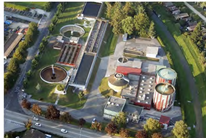
Vue aérienne de la station d'épuration d'Yverdon. (A-) Image: Olivier Allenspach (A)
