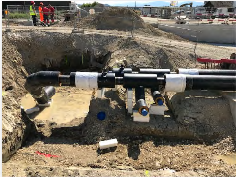
Tubes CAD Santal dans le secteur APA côté Y-Parc, 16 juillet 2019.
