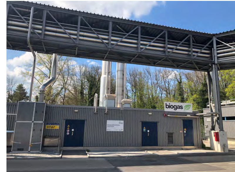
Source : Installation de biogaz Werdhölzli, Energie 360°
