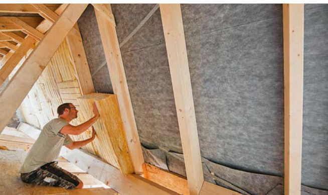
Travaux d'isolation ( www.maison-travaux.fr )
