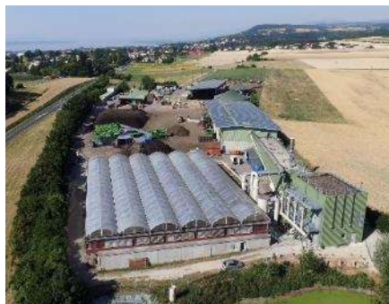
Usine de biogaz
