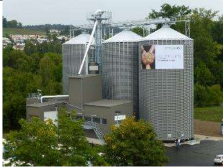
Silos de stockage de granulés de bois
