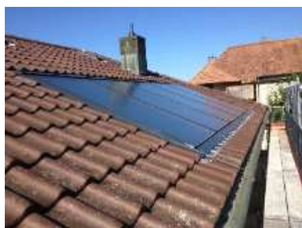
Installation solaire thermique intégrée
