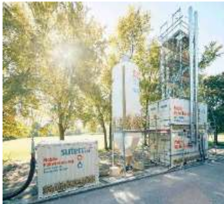
Installations mobiles de chauffage aux granulés de bois
