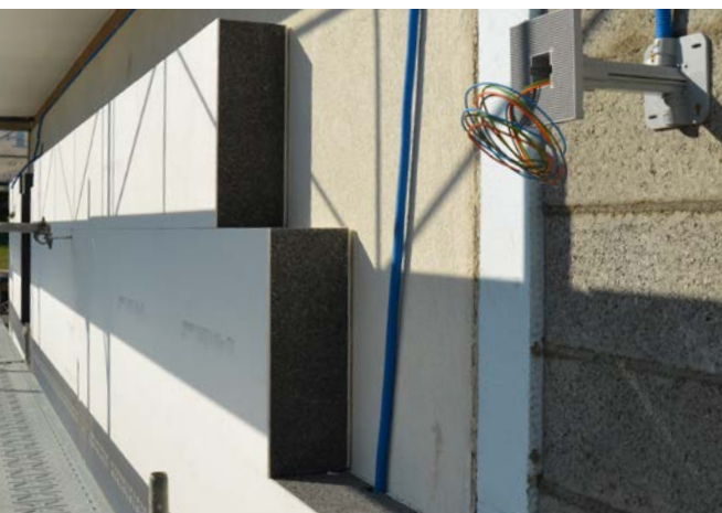
Isolation thermique des façades d'une maison d'Ardon, subventionnée par la commune
