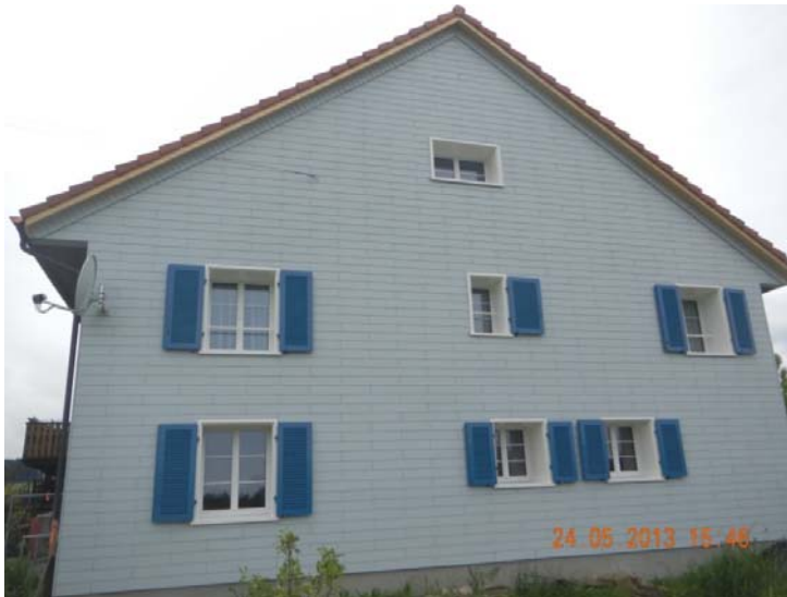
Illustration 4: La façade rénovée de la maison paysanne.
