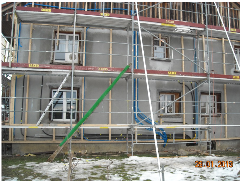
Illustration 3: Installation des conduites dans la couche d'isolation: les conduites noires sont pour le chauffage et les conduites bleues, pour le câblage électrique.
