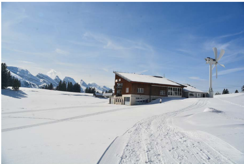
Énergies éolienne et solaire à l'alpage et station de téléphérique de Gamplüt, commune de Wildhaus.
