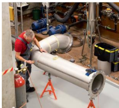
Installazione della rete di anergia
