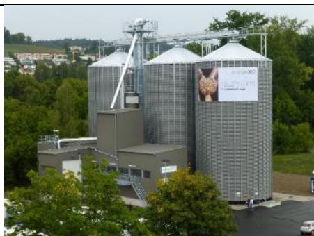
Silo di stoccaggio per pellet di legno
